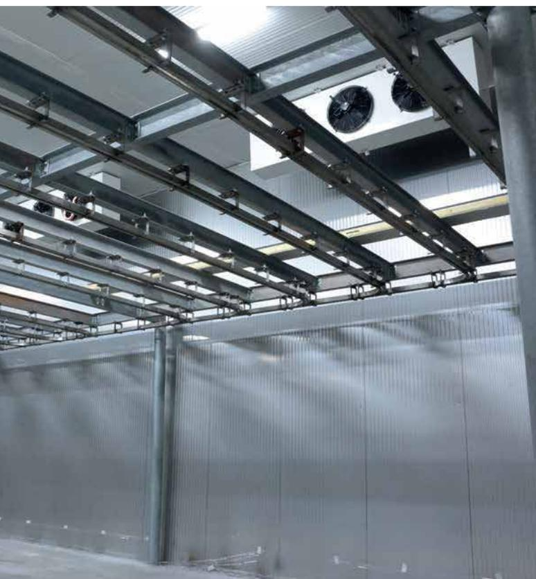
самой дополнительной особенностью этих камер являются полиуретановые панели, которые составляют холодную камеру. Предоставлен выбор 8, 10, 12, 15, 18, 20 см, в зависимости от использования теплоты. Наши панели с плотностью полиуретана (40-42 кг / м).
